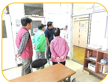
消防設備の 操作方法確認
