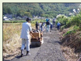
未舗装農道の舗装
