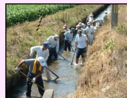
水路の泥上げ
