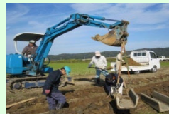
コンクリート水路の更新
