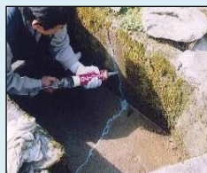
ひび割れの補修
