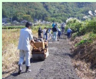
未舗装農道の舗装
