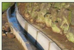
素堀り水路からの更新
