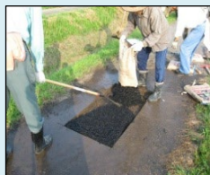
農道の部分補修
