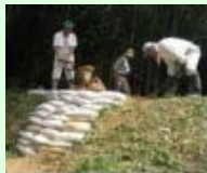
漏水箇所の補修
