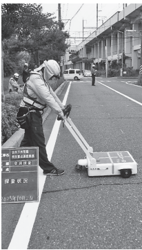
レーザー探査による空洞調査
