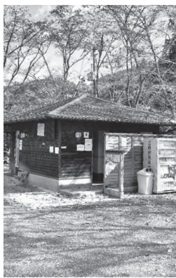
改修される御調八幡宮のトイレ
