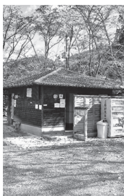
改修される御調八幡宮のトイレ
