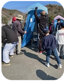
マンホールトイレ設営
