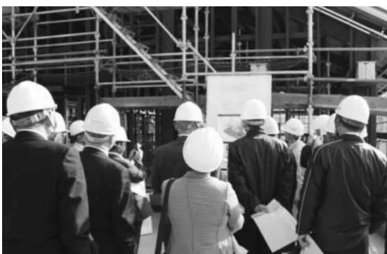
建設中の道の駅「みはら神明の里」
