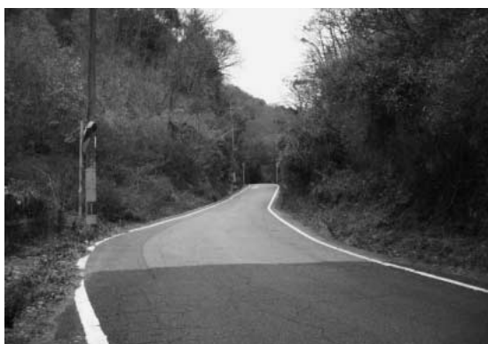
県道三原本郷線 井屋峠付近
