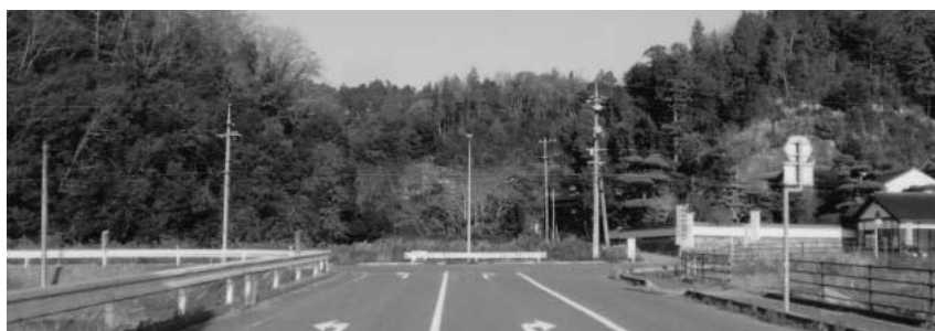
広島空港へのアクセス道路 高坂本郷線入口付近
