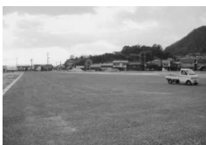
幸崎町能地漁港埋立地
