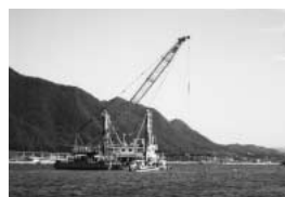
佐木～小佐木 海底送水管修理現場 小佐木柄鎌瀬戸
