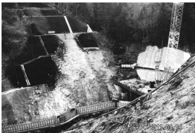
久井地域の水源 工事中の野間川ダム
