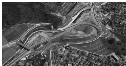
道の駅建設予定地
