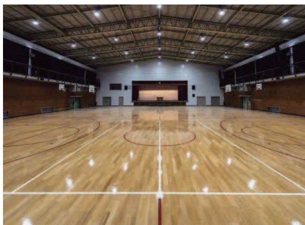
長寿命化工事で改修された中学校の体育館アリーナ
