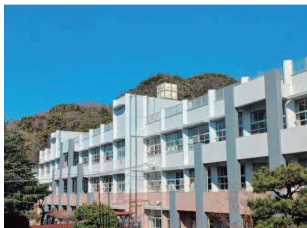
長寿命化工事で改修された小学校の校舎
