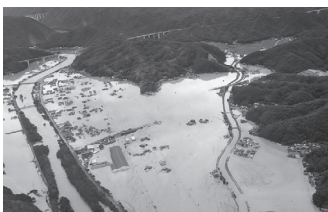
大きな被害が発生した平成30年7月豪雨災害
