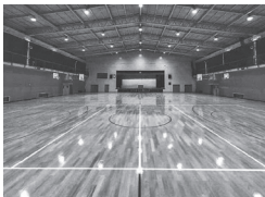
LED化した体育館照明
