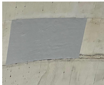
FRP ネット剥落防止実施例
