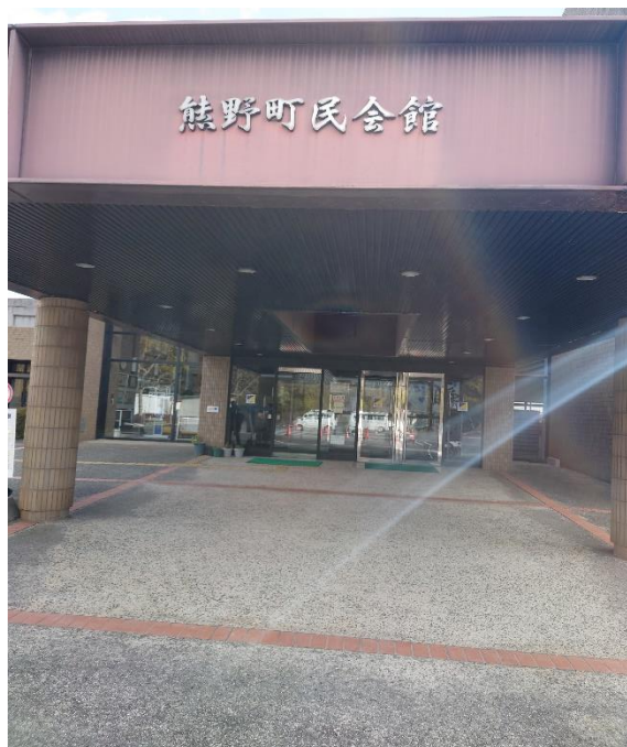
＜中央防災センター（熊野町民会館）＞
