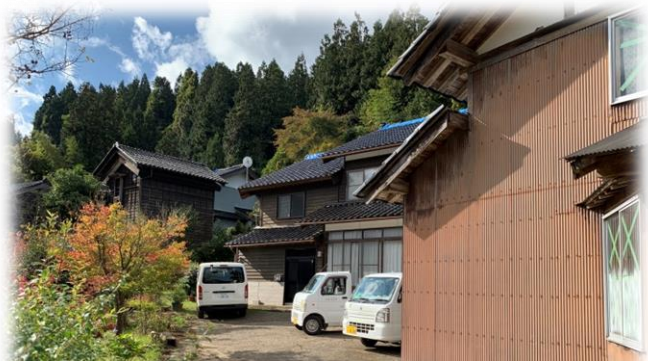
母屋は地震の被害が殆どない状態
