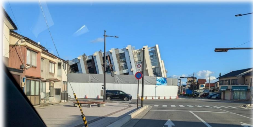
根元から倒壊した7階建てのビル 解体は始まっているが殆ど地震当初のまま
