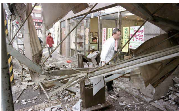
広島市西区 広電 西広島駅付近
