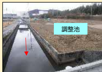
工事中の沼田西町松江地区
