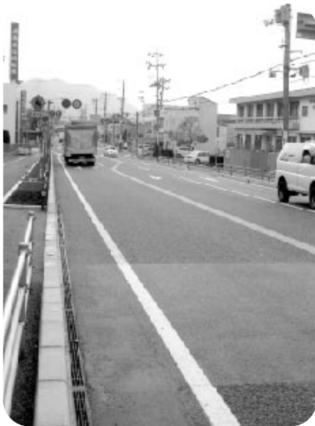
緊急輸送道路に指定されている国道2号
