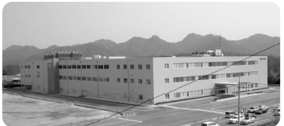
増産体制の整備が進む三原西部工業団地の工場
