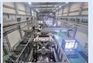
より良い製品を生む高性能の設備
