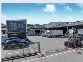
成形工場に組立工場、 出荷センターも併設
