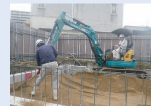
交番を新築するための基礎工事
