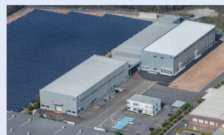
手前から第1工場、第2工場、第3工場
