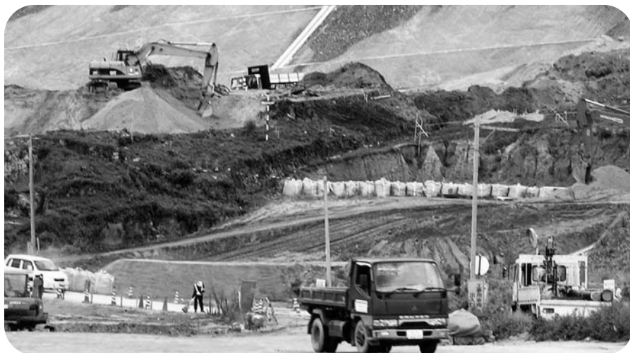
▲競争入札で契約した公共工事の現場
