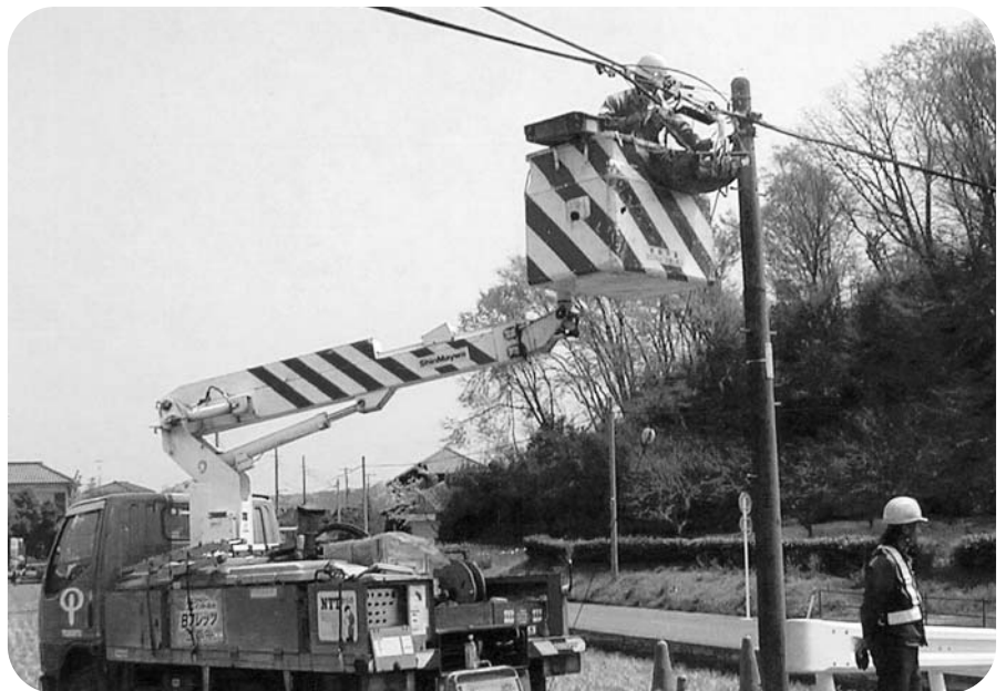
▲着実に進む光ケーブルの架設工事
