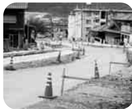
▲整備が進む糸崎町の工事現場
