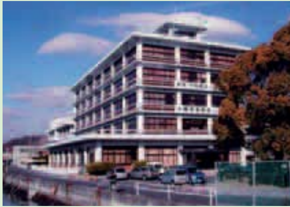
手狭になっている現在の庁舎
