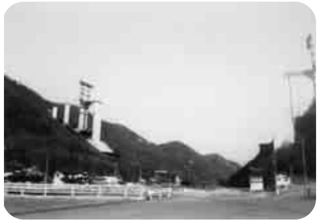
▲広島空港大橋の建設現場
