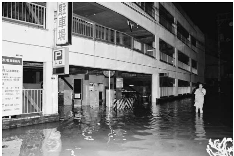
市営帝人通駐車場付近の浸水状況
