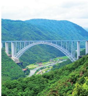
広島スカイアーチの愛称で親しまれる広島空港大橋は、広島中央フライトロードに架かる橋です。平成23年に完成し、全長800m、地上から橋面の高さ約190m、アーチの根元から根元までの距離「アーチ支間」は380mあり、沼田川や県道、JRの線路を跨ぐ造りです。また、建設時に橋を支えるために使用したワイヤの耐力はとても強く、たった2本でジャンボジェット機(約380tのボーイング747-400)を吊り上げることができます。
