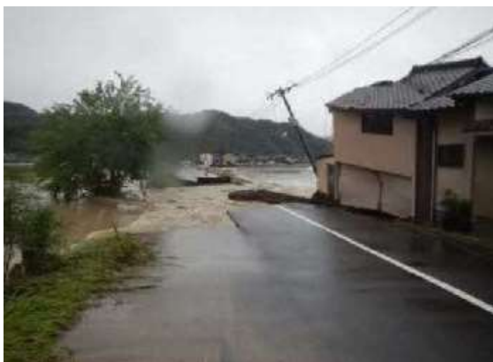
仏通寺川の破堤状況
