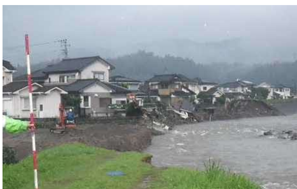
河岸侵食による家屋の倒壊(花月川)
