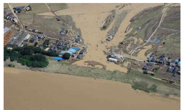
堤防決壊による家屋の流失(鬼怒川)
