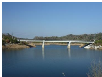
三河橋 L=106.0m(PC橋) 1999年架設
