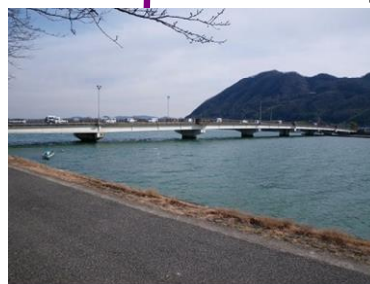
沼田大橋 L=316.0m(PC橋) 1996年架設
