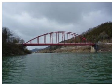
中央大橋 L=80.2m(鋼橋) 1969年架設
