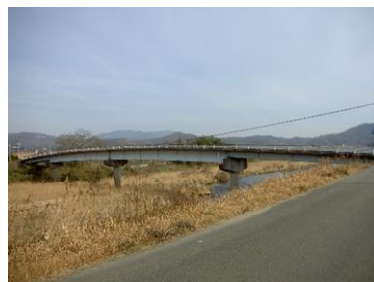
船木大橋 L=102.6m(鋼橋) 1970年架設
