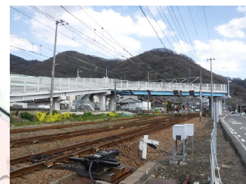
糸崎122号線3号橋梁 L=118.0m(PC橋) 1963年架設
