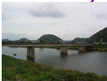
本市橋 L=110.0m(PC橋) 1964年架設
