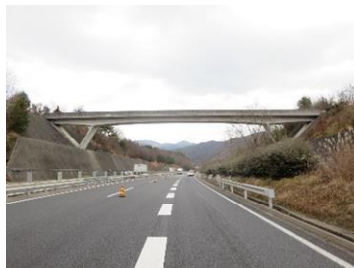
仏通寺橋 L=69.2m(PC橋) 1993年架設
