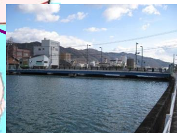
曙橋 L=52.9m(PC橋) 1999年架設
