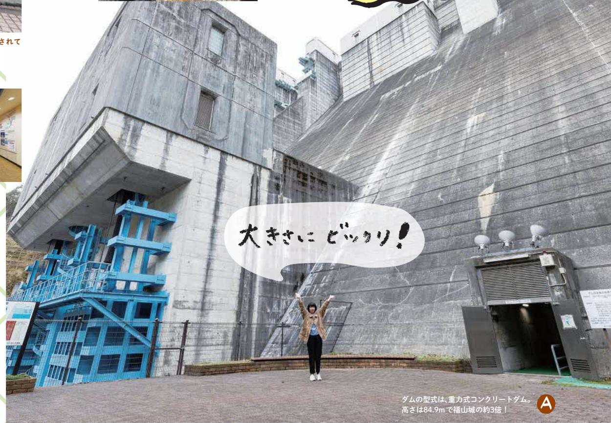
**A** ダムの型式は、重力式コンクリートダム。高さは84.9mで福山城の約3倍!
