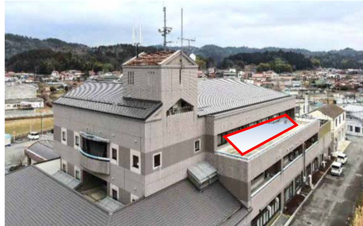
▲太陽光発電設備設置場所
