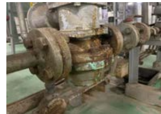
▲ 減温塔ガス冷却配管の現況
