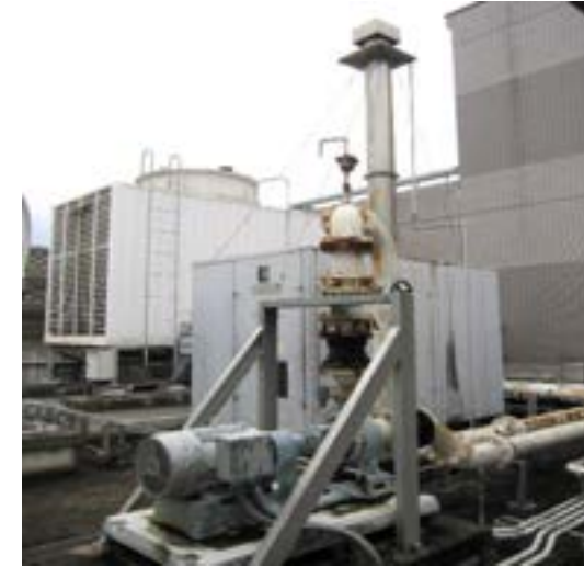
▲空調設備の改修
