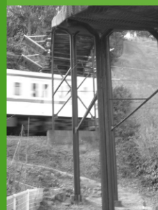
空中参道の下を通り抜ける呉線。高架の骨組はレールが使われている。
