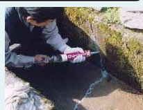
水路のひび割れ補修
