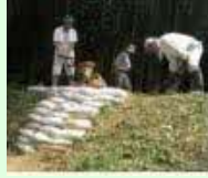
漏水箇所の補修
