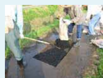
農道の部分補修
