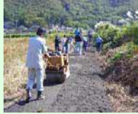
未舗装農道の舗装
