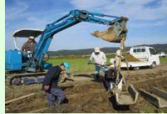
コンクリート水路の更新
