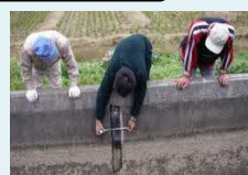
施設の機能診断
