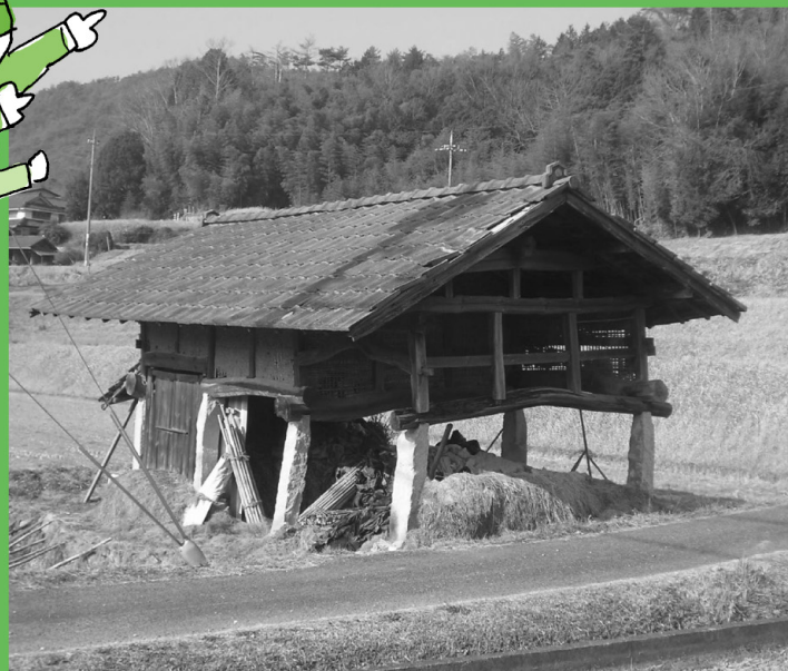
昔から農家の別棟として、田んぼの横に作られていた肥料づくりの作業小屋。火を使うため石や土を使った独自の構造になっている。(下徳良にて)
