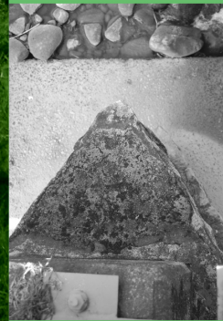
これが真上から見たとんがり橋脚の水切りだ。この角度が水の抵抗をやわらげる役目をする。三原城の水はねにも似ている。
