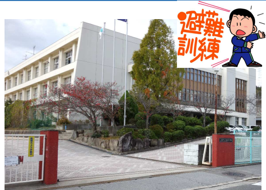
宮浦中学校（市が開設する避難所）
