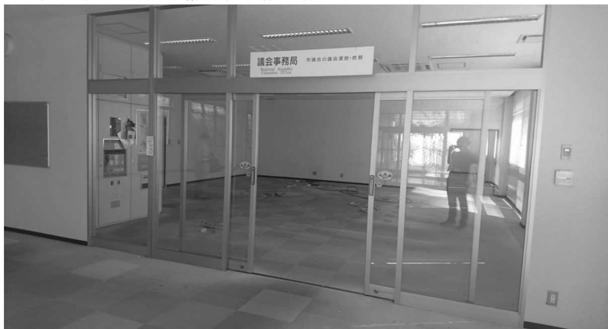
入口側（西側）から旧議会事務局事務室内を撮影
