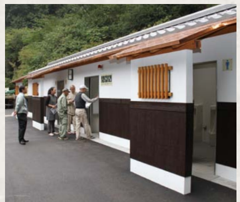
▲第2駐車場内に完成した新しいトイレ
