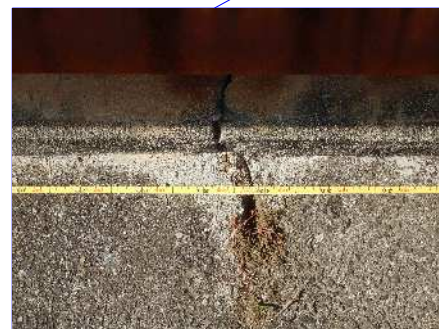
伸縮目地部の土砂堆積(路面)
