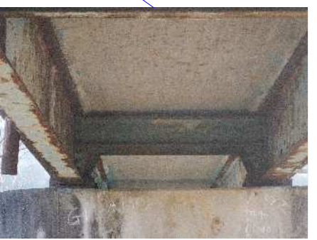
中間支点横桁部
