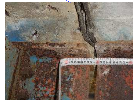
伸縮目地材の脱落(床版下面)
