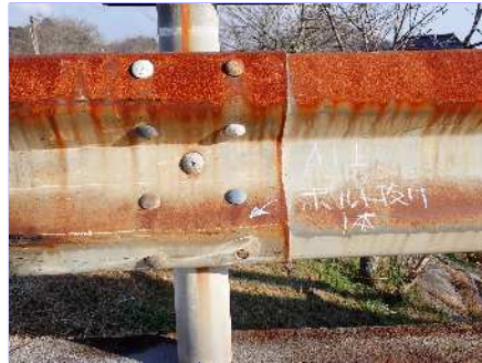
ガードレールボルト抜け (M16-1本)
