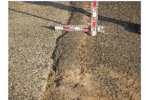
パラペット天端部舗装突起
