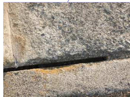
伸縮目地材の脱落
