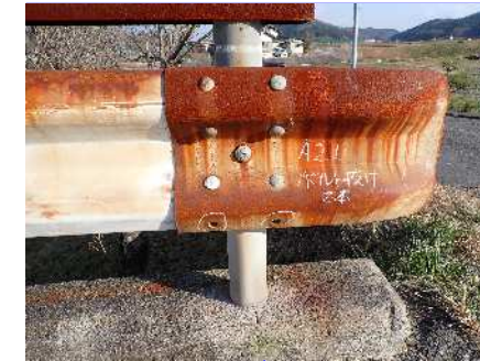
ガードレールボルト抜け (M16-2本)
