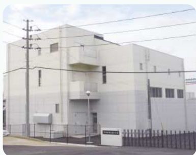
▲完成した下北方雨水ポンプ場
