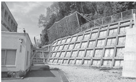
深小学校上地区急傾斜地崩壊対策工事
