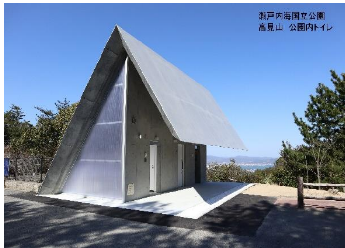
瀬戸内海国立公園高見山公園内トイレ
