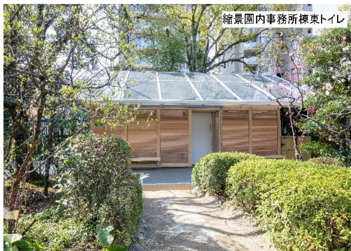
縮景園内事務所棟東トイレ
