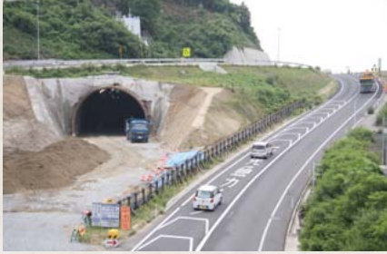
▲来年3月に全線開通予定の三原バイパス
