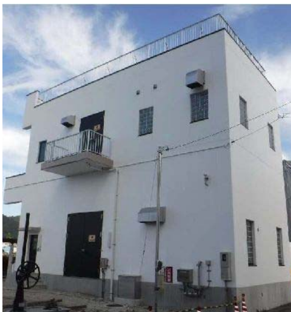
図表 3 城町第 3 雨水排水ポンプ場（令和 3 年 12 月供用開始）
