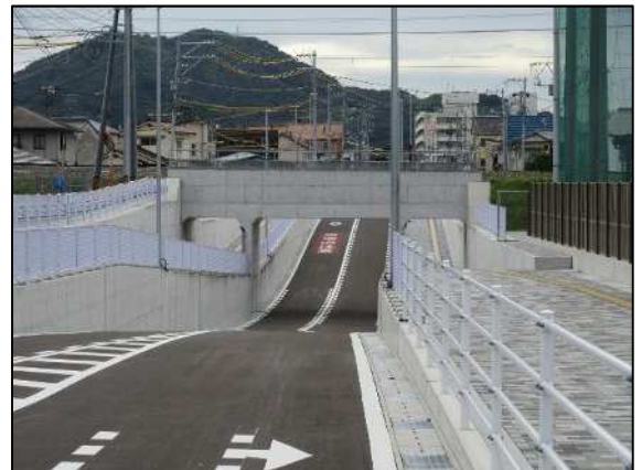
皆実88号カルバート
