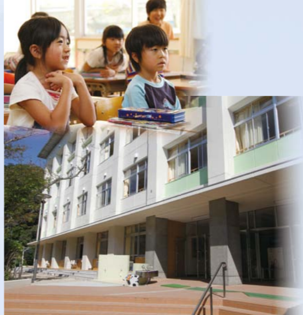
▲昨年度、耐震補強工事をした西小学校の校舎
