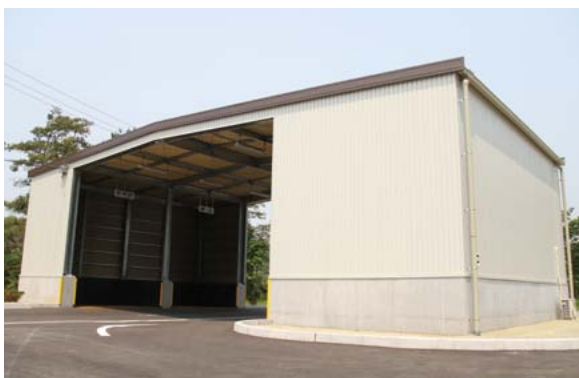
▲古紙類を一時的に保管し、再資源化につなげるストックヤード
